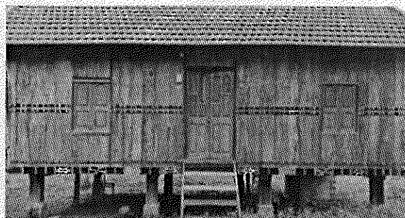
Hình 8. Hiện trạng công trình nhà Rông
